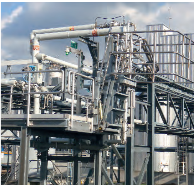
Tanknotdusche in Leitung eingeschliffen / Freier Auslauf DIN 1717
